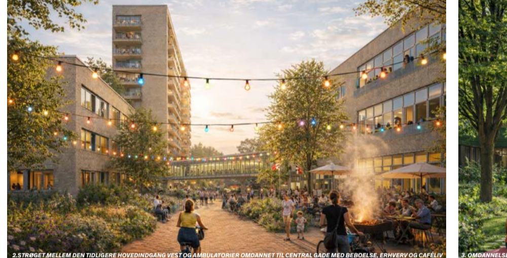
2. STRØGET MELLEM DEN TIDLIGERE HOVEDGANG VEST OG AMBULATORIER OMDANNET TIL CENTRAL GADE MED BEBOELSE, ERHVERV OG CAFÉLIV
