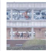
bygning 67 machizukuri eksempel bygning med fælles arbejdspladser anvendt til blandede brug af kreativt design, konger og forskningsstudier
