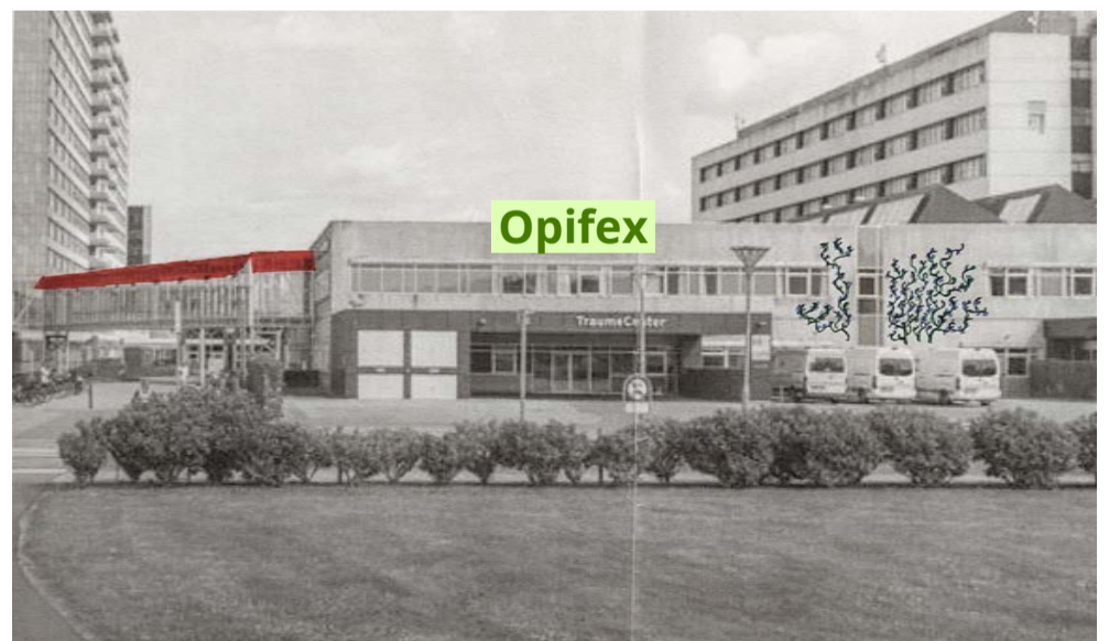
Facade til Opifex med markise, skilt og klatreplanter
